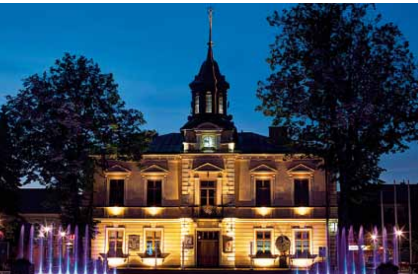
DZIEWIĘTNASTOWIECZYNY, PIĘTROWY BUDYNEK RATUSZA W NOWYM TARGU, ZWIĘCZONY WIEŻĄ Z ZEGAREM ■ THE 19 TH -CENTURY, STOREYED BUILDING OF THE TOWN HALL IN NOWY TARG, CROWNED WITH A CLOCKTOWER ■ MEHRSTÖCKIGES RATHAUSGEBÄUDE AUS DEM 19. JAHRHUNDERT IN NOWY TARG, DURCH EINEN UHRTURM GEKRÖNT
