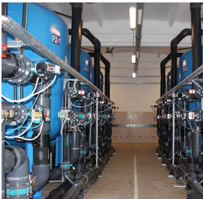
Stacja uzdatniania wody w Nisku
