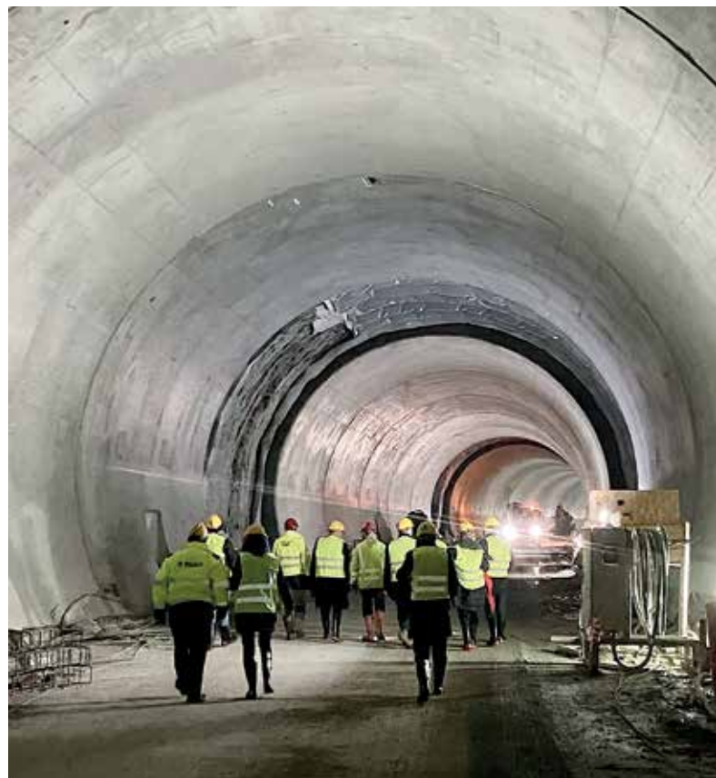
Slovenská spoločnosť Uranpres dokončuje v Poľsku tunely TD1 a TD2 z obchvatu Węgierskej Górky na rýchlostnej ceste S1 smerom na Slovensko.
