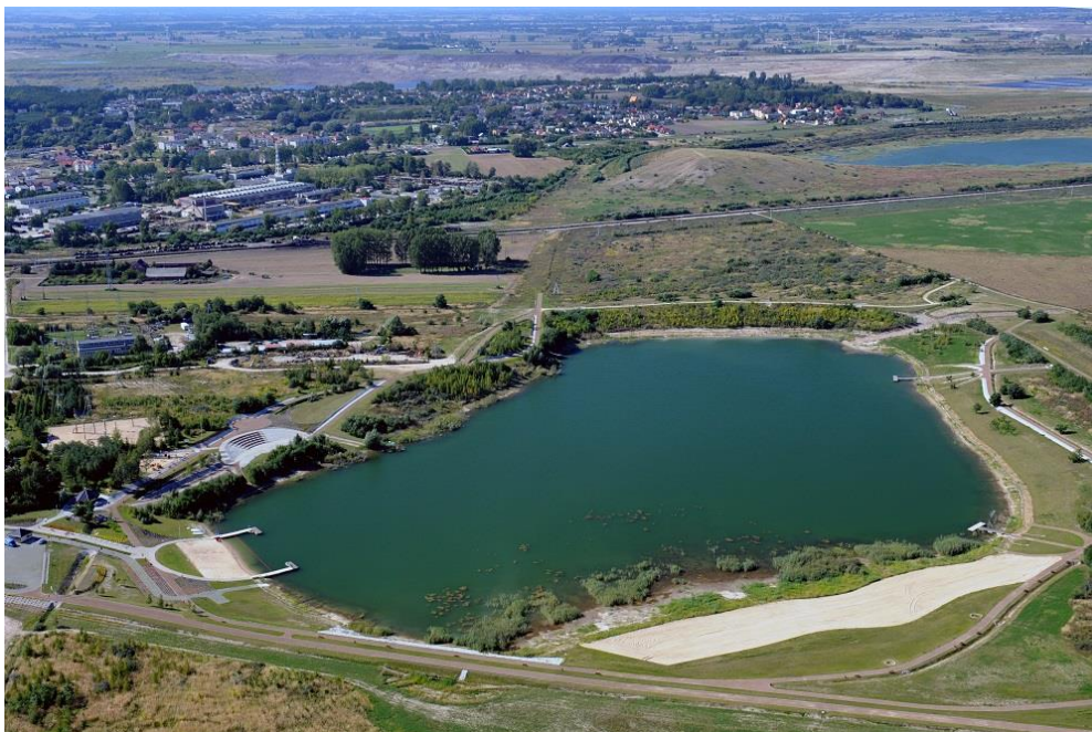
Rysunek 21. Przykład rekultywacji wyrobiska poeksploatacyjnego w kierunku zbiornika wodnego i parku rekreacji po Odkrywce Józwin
