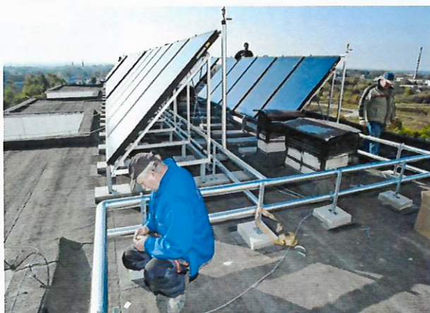
Rys. 1.13 Instalacja kolektorów słonecznych na dach budynku spółdzielni. Autor: Wojciech Pacewicz (PAP)
