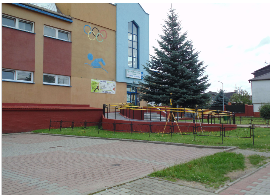
Fot.3. Rejon badań, widok w kierunku północno - wschodnim
