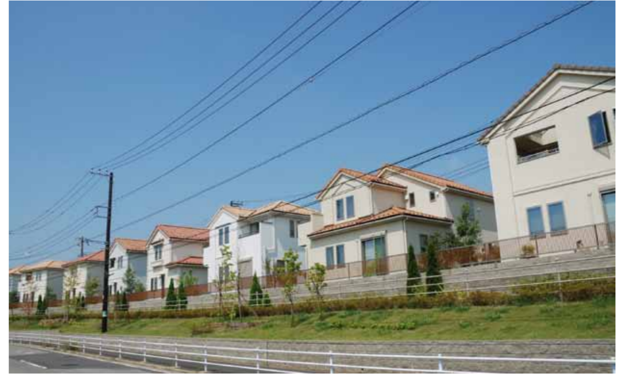
Rysunek 13. Widok ulicy małego miasta z napowietrznymi liniami niskiego napięcia oraz przyłączami domowymi.
