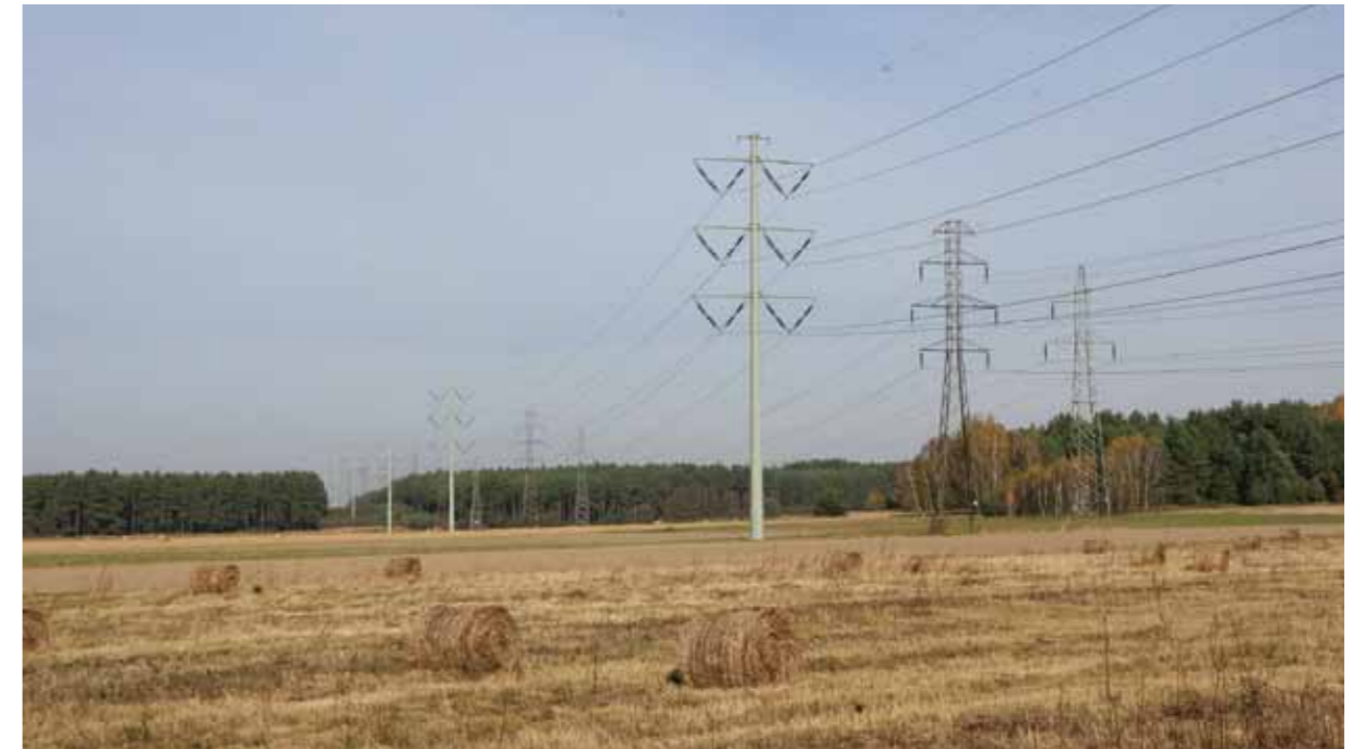
Rysunek 19. Widok słupa rurowego dwutorowej linii elektroenergetycznej 220 kV oraz słupów kratowych linii 110 kV.
