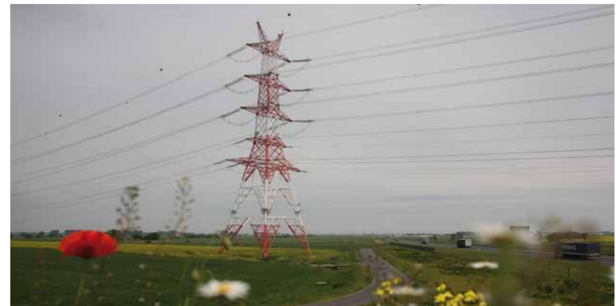
Rysunek 9. Widok dwunapięciowej linii elektroenergetycznej 400/220 kV.
