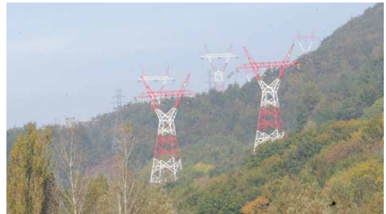
Rysunek 20. Widok napowietrznej, jednorodowej linii elektroenergetycznej o napięciu 400 kV w terenie podgórskim.
