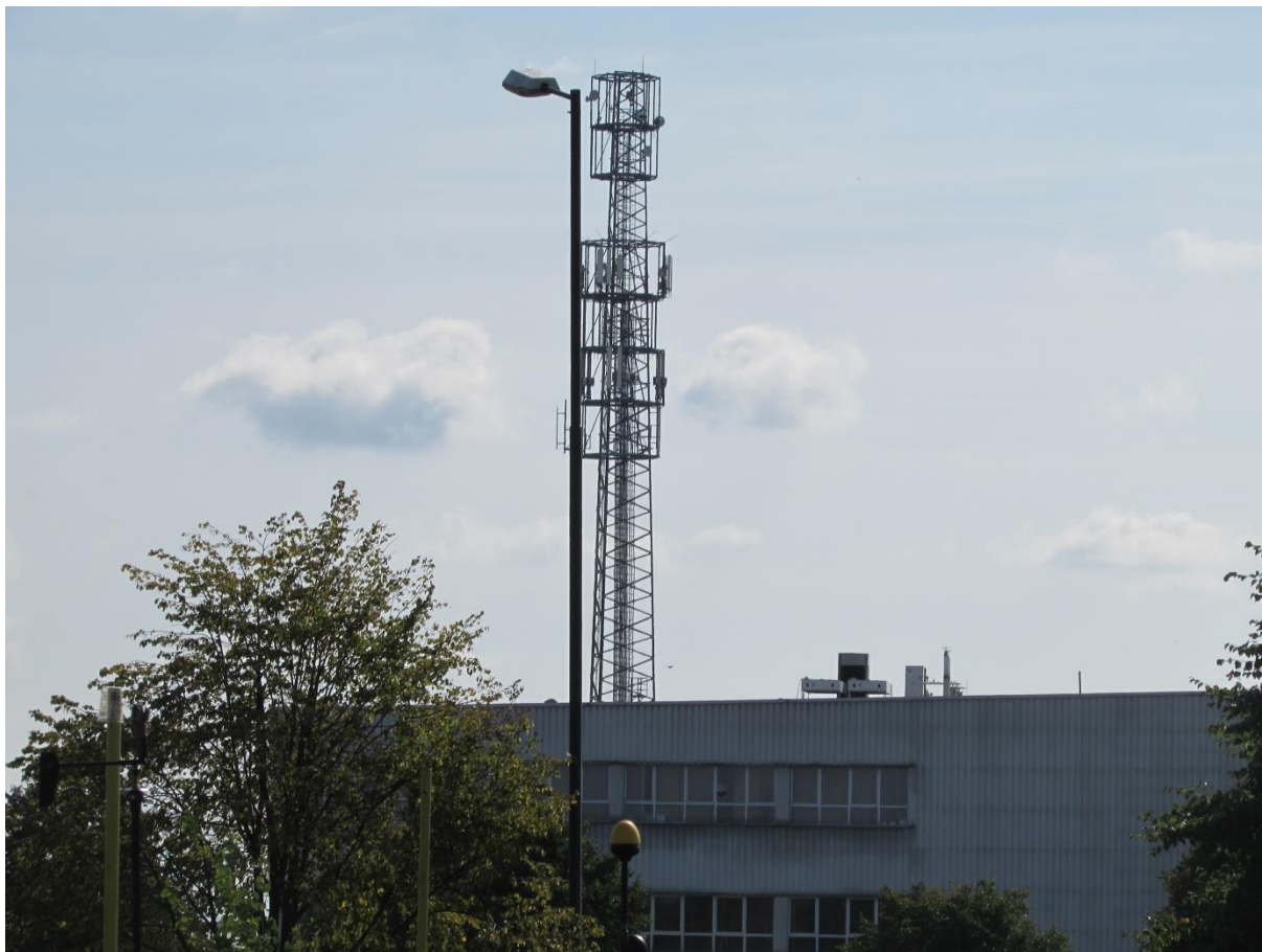
Fot. 1 Rejon badań, widok w kierunku południowo - wschodnim (SE)
