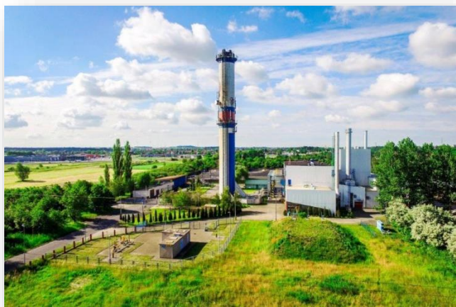
Rys. 26 Ostrowski Zakład Ciepłowniczy - to na jego bazie miasto zaczęło rozwijać własną infrastrukturę energetyczną
