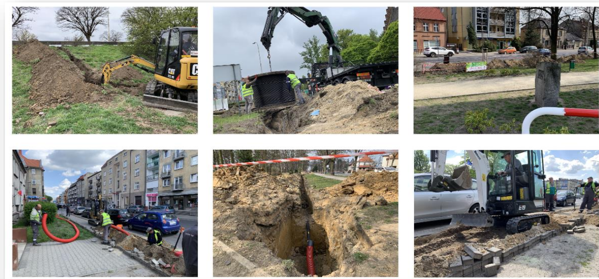
Rys. 28 Budowa sieci kablowej w Ostrowie Wielkopolskim
