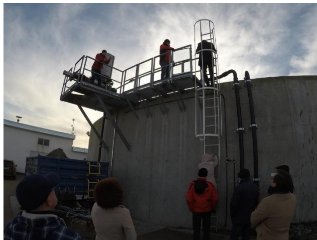
Rys. 46 Biogazownia rolnicza w Michałowie. Fot. IEN Energy.
