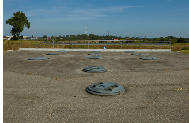
Fot. 4. Komory obiektu numer 3a
