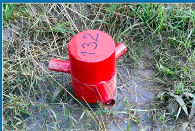
Piezometr nr 132 służący do pobierania próbek wody
