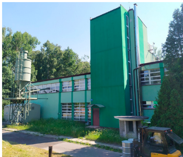
Fot. 4. Stacja Unieszkodliwiania Odpadów Promieniotwórczych. W najwyższej części budynku znajduje się instalacja wyparna. Po lewej widoczny silos na cement instalacji cementowania (fot. KSOP) Photo 4. Radioactive Waste Conditioning and Treatment Station. In the highest part of the building the evaporative installation is located. On the left, a cement silo for the cementing installation can be seen
