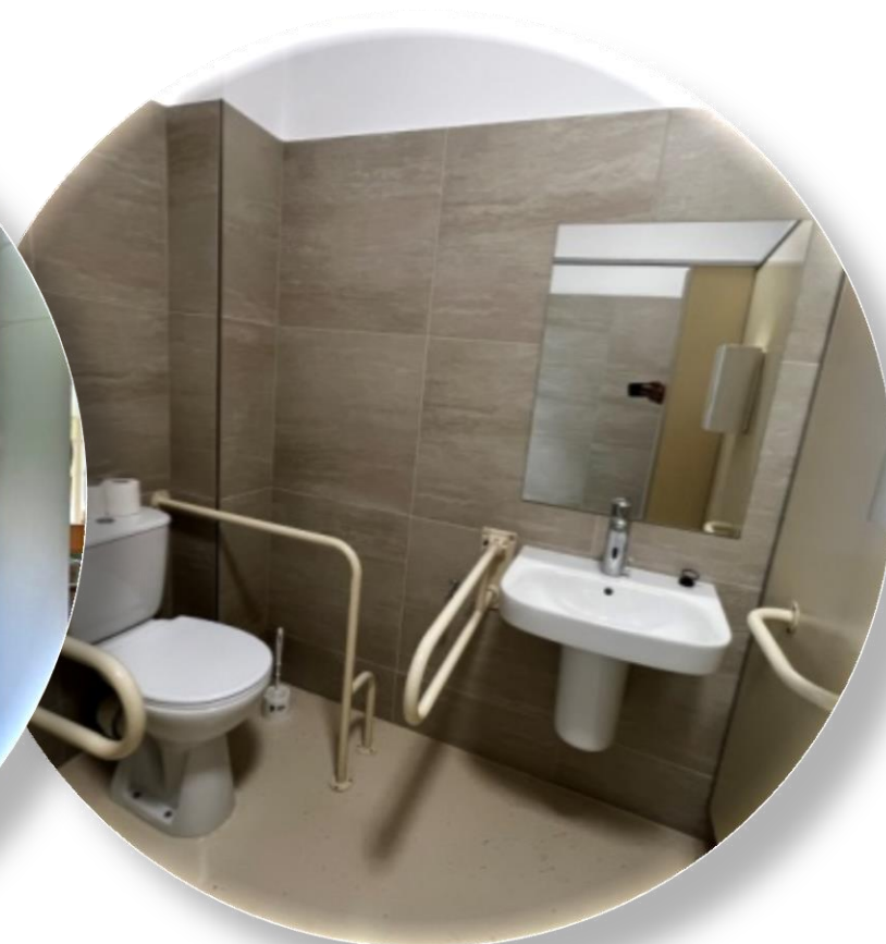
Dostępność pomieszczeń sanitarnych
