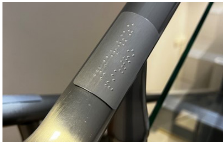
Zdjęcie 5 : Oznaczenia dotykowe zawierające informacje w alfabecie Braille'a zakonotowane na poręczy w Sądzie Apelacyjnym w Poznaniu
