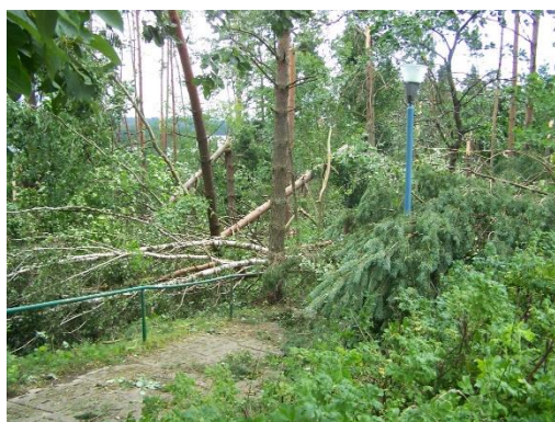
Ciąg komunikacyjny prowadzący do jeziora oraz domków letniskowych
