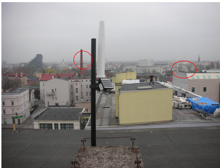
Rys. 3 Miejsce montażu pilotażowego SMS PEM – UM Bydgoszcz – widok na anteny SBTK
