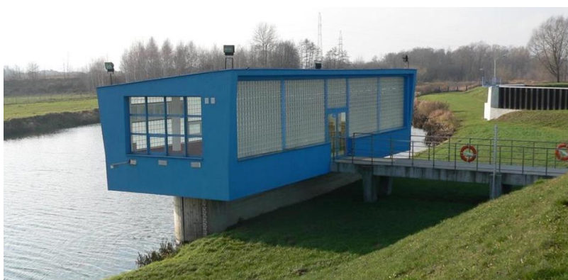
Fot. 4. Ujęcie wody surowej na Rzece Wisłok przy ul. Zwiączyckiej w Rzeszowie.
