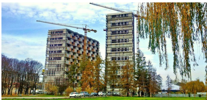
Fot. 10. Budynki mieszkalne, wielorodzinne przy Al. Powstańców Warszawy w Rzeszowie.
