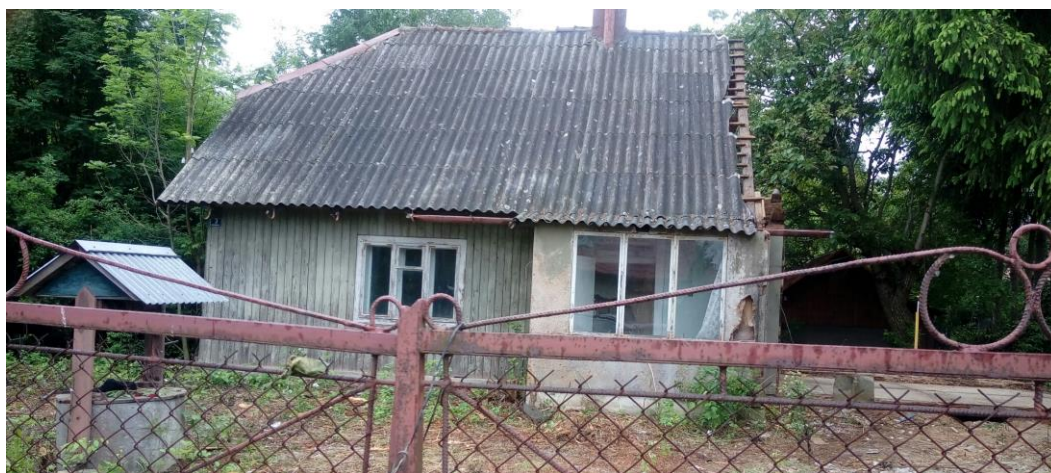
Fot. 2. Rozbiórka budynku mieszkalnego z dachem zawierającym azbest.
