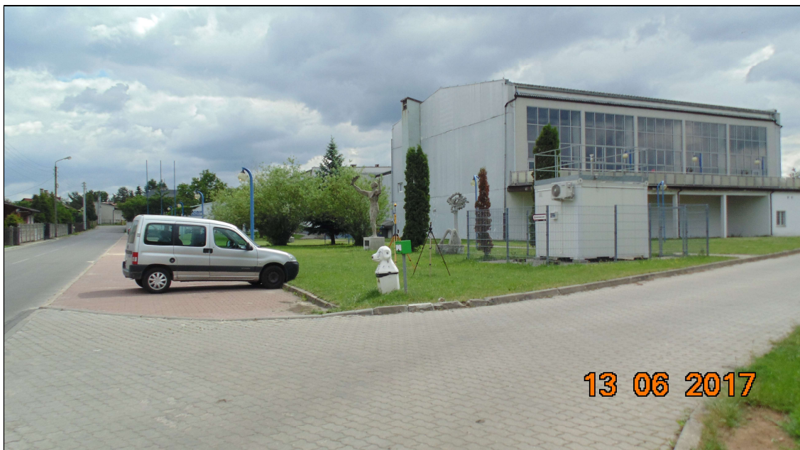
Fot.2. Rejon badań, widok w kierunku południowo-wschodnim– zabudowa MOSiR
