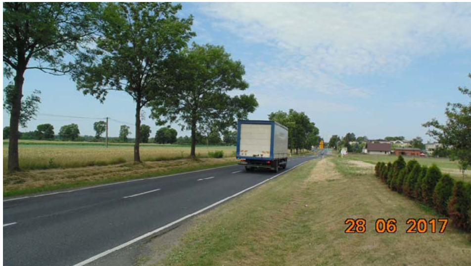
Fot. 2. Lelów, RB1. Badany odcinek ul. Szczekocińskiej w kierunku Częstochowy
