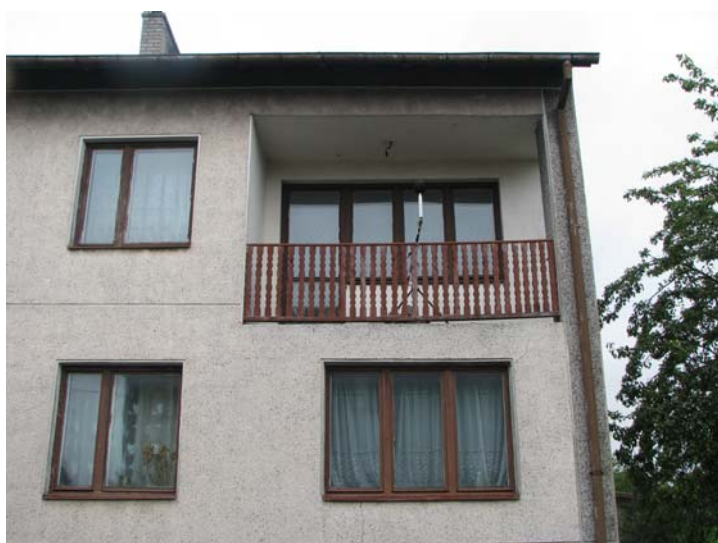
Fot. 10. Lelów, RB4. Lokalizacja punktu pomiarowego przy ul. Krakowskiej
