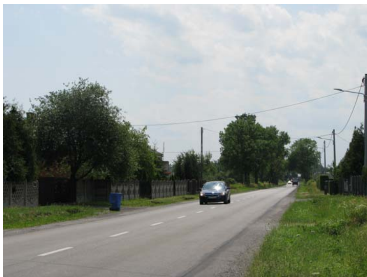
Fot. 9. Drochlin, RB3. Badany odcinek DW 794 w kierunku Lelowa
