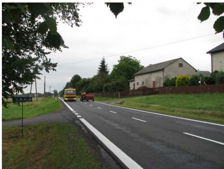
Fot. 15. Ślężany, RB5. Badany odcinek DK 46 w kierunku Lelowa
