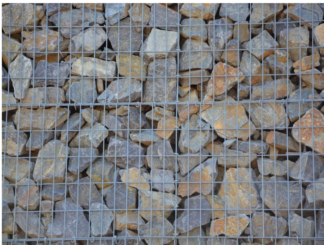
Fot. 1. Przykład zastosowania gabionowych materacy Reno (źródło: Gabion Solutions Ltd.)
