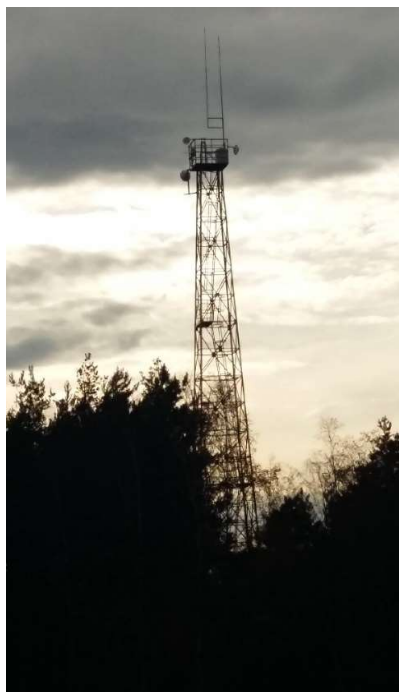
Zdjęcie 2. DOSTRZEGALNIA PRZECIWPÓŻAROWA Z UMIESZCZONĄ NA WIERZCHOŁKU KAMERĄ W LEŚNICTWIE STRACHÓW.
