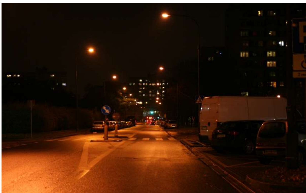
Rys. Z.8.2. Widok instalacji oświetleniowej – przypadek 2
