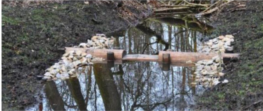
Ryc. 82. Przykład progu spowalniającego odpływ wód powierzchniowych zamontowanego w nadleśnictwie Babimost w ramach projektu Mala retencja nizinna (źródło: babimost.zielonagora.lasy.gov.pl ).
