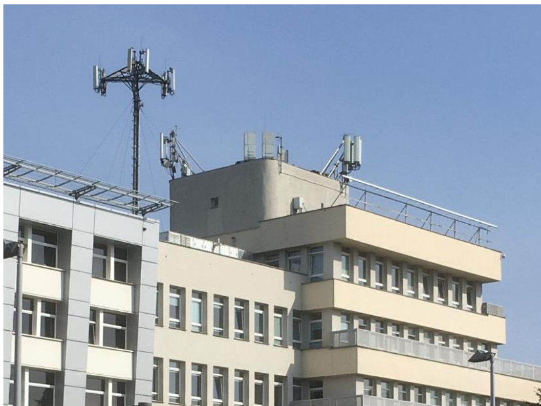
Fot. 1: Widoki anten stacji bazowych: ID: GDA0029_A, ID: 30004 (40004N!), zlokalizowanych od adresem: ul. Biała 1, ul. Zawiszy Czarnego 18; 80-435 Gdańsk
