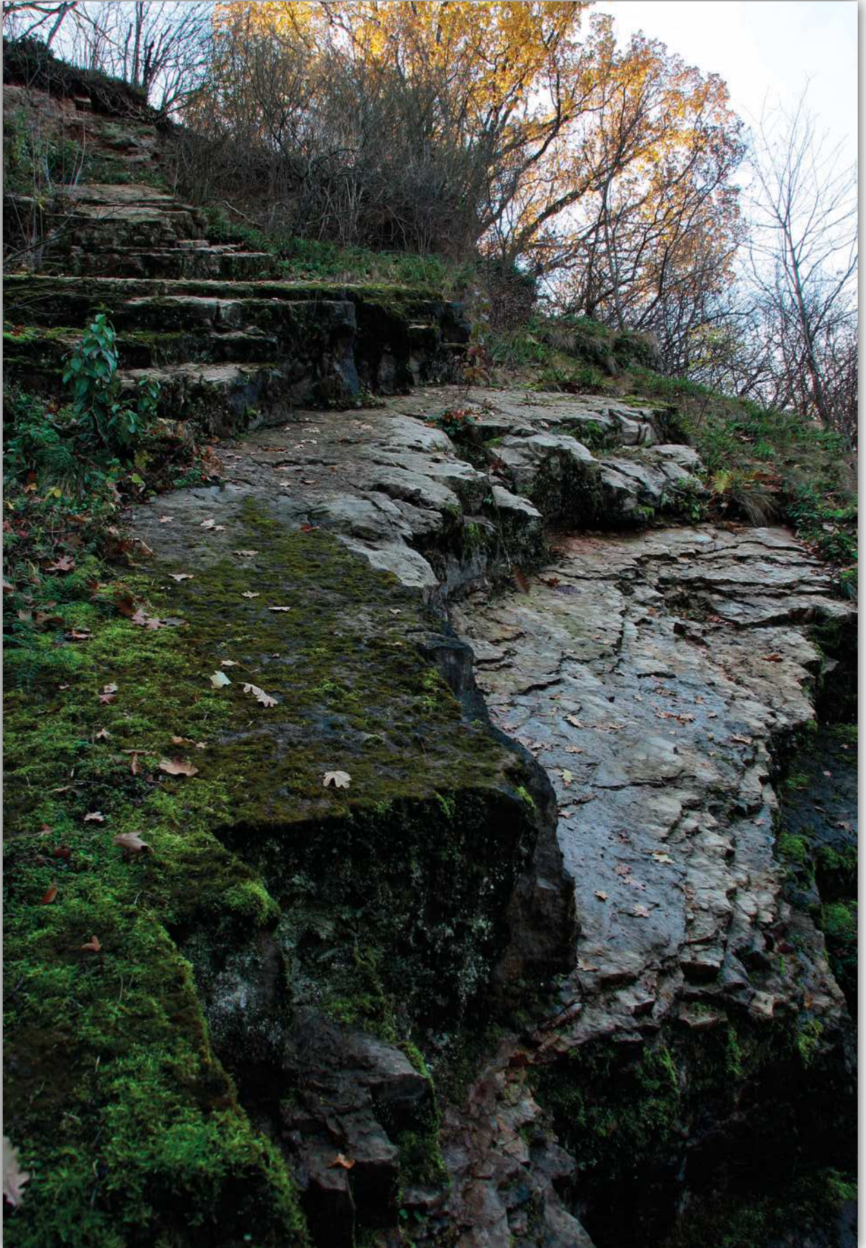
Płytowa budowa skał dolomitowych południowego zbocza wąwozu
