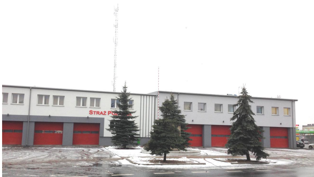
Fot. Termomodernizacja budynków KM PSP w Siedlcach.
