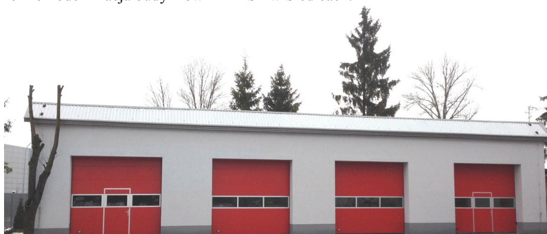
Fot. Termomodernizacja budynków KM PSP w Siedlcach – budynek garażowo-magazynowy.
