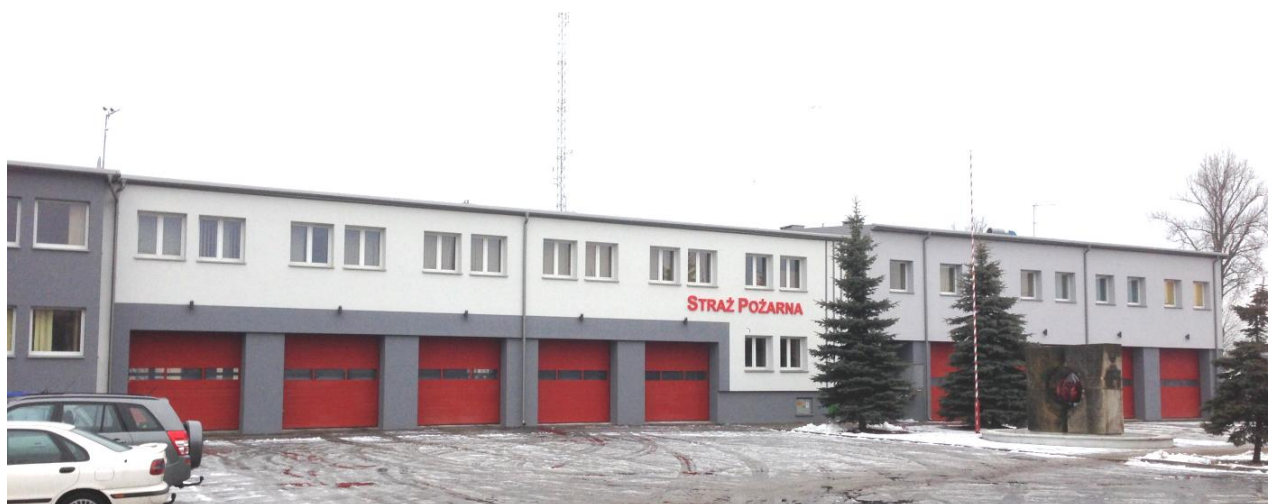
Fot. Termomodernizacja budynków KM PSP w Siedlcach.
