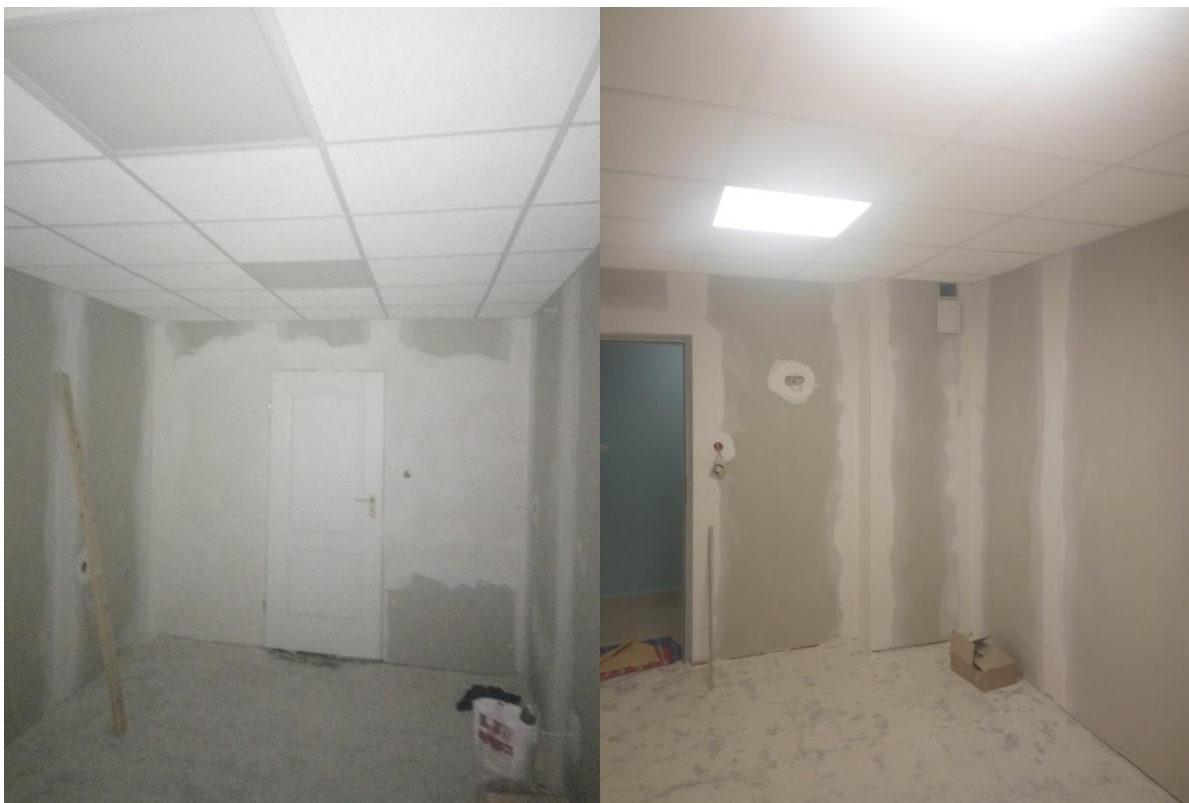
Fot. Remont pomieszczenia socjalnego.
