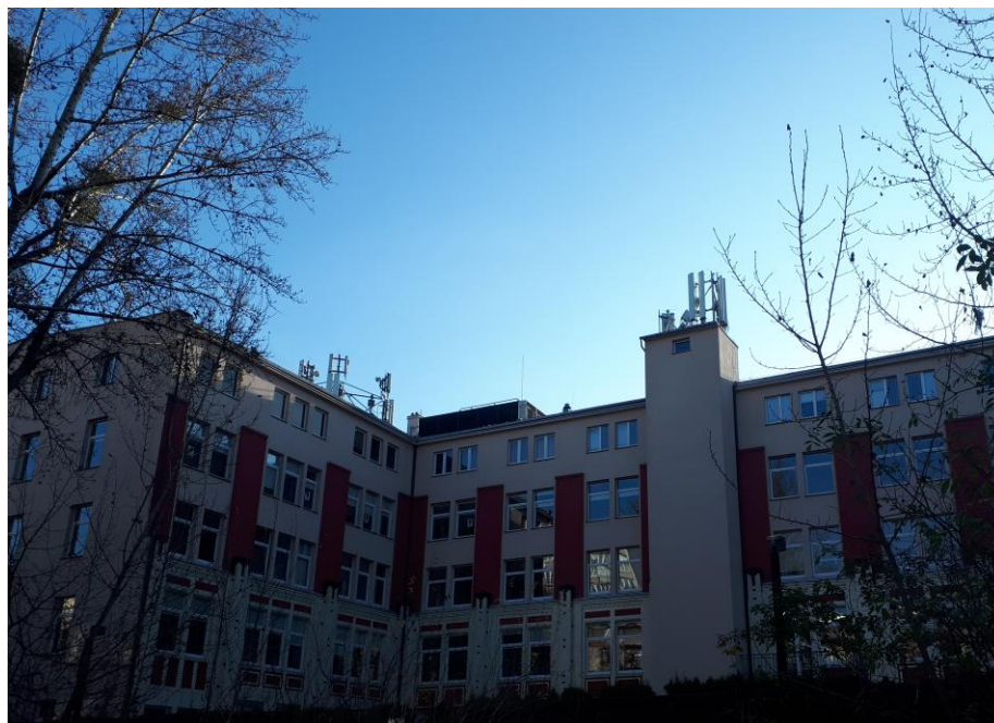
Fot. 1: Widok anten stacji bazowych: ID: WRO1187, ID: BT33394, ID: 2417 (77042N!), zlokalizowanych pod adresem: ul. Prosta 36, 53-508 Wrocław
