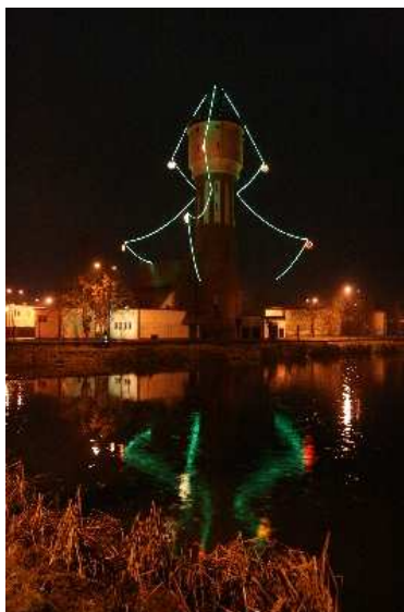
Stacja Uzdatniania Wody - Września
