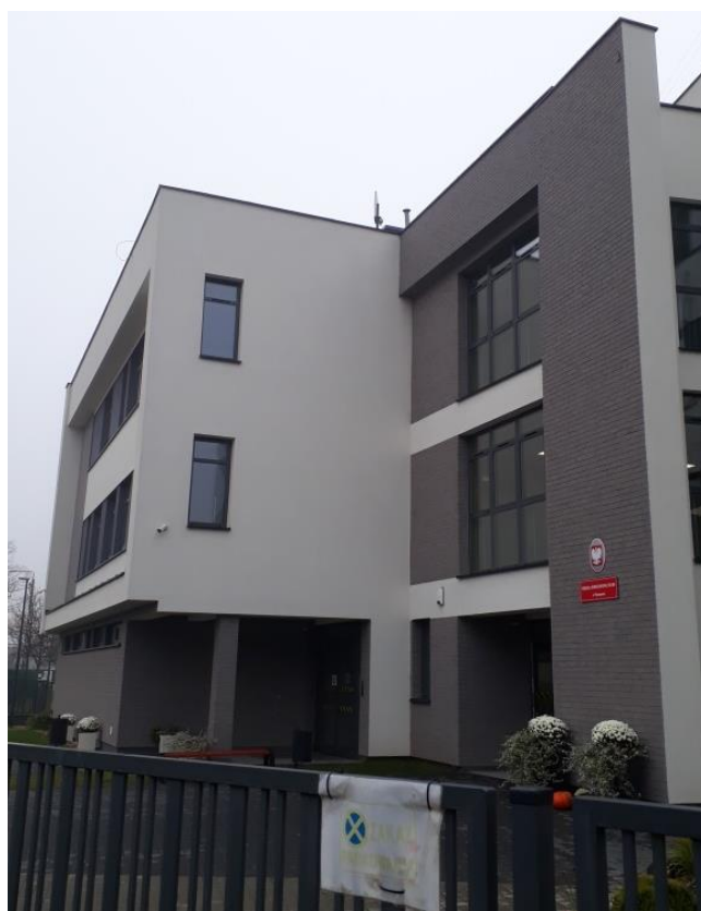
Rys. 3 Miejsce montażu SMS PEM – Szkoła Podstawowa nr 404, Warszawa – widok z poziomu gruntu
