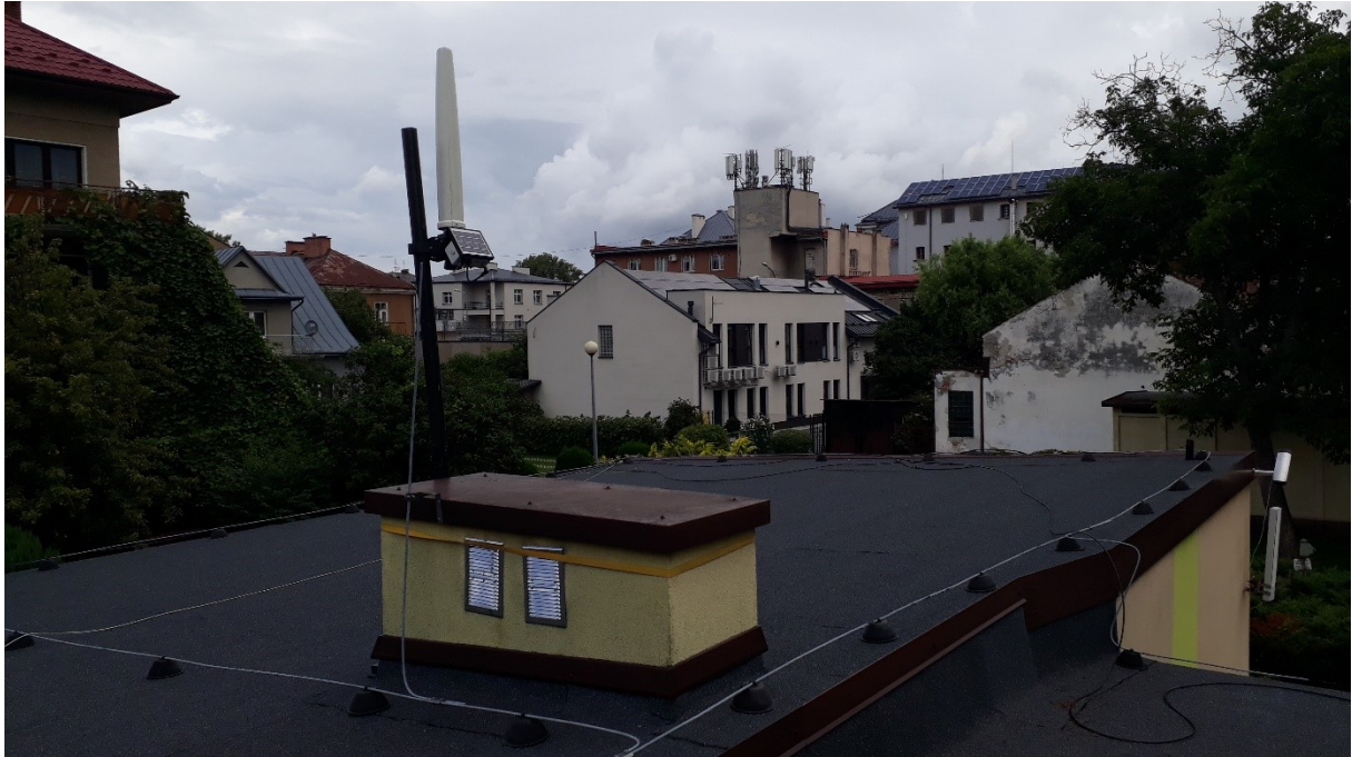
Rys. 3 Miejsce montażu SMS PEM – Przedszkole Publiczne nr 13 w Tarnobrzegu – widok na SBTk
