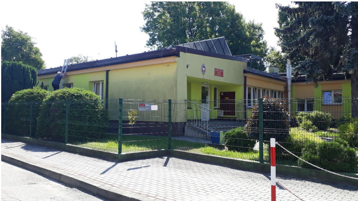
Rys. 2 Miejsce montażu SMS PEM – Przedszkole Publiczne nr 13 w Tarnowie – widok z poziomu gruntu
