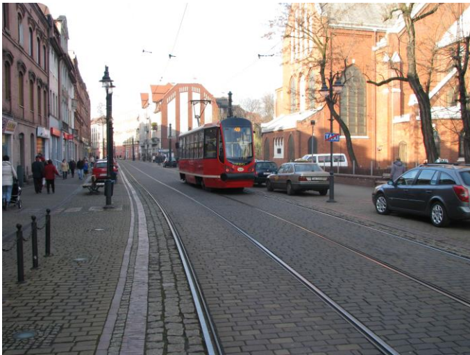
Fot. 2. Świętochłowice, RB1. Linia tramwajowa w ciągu ul. Katowickiej w kierunku Bytomia
