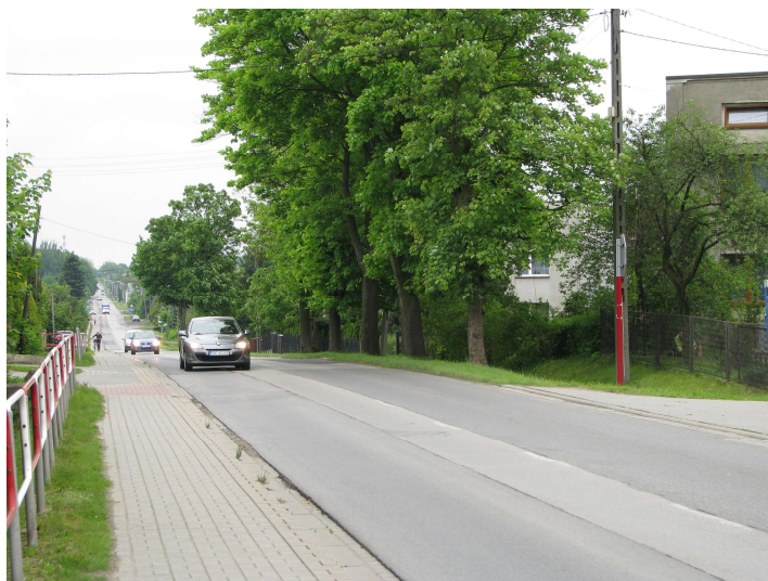
Fot. 9. Strzyżowice, RB3. Badany odcinek ul. Szosowej (DW 913) w kierunku Gródkowa.
