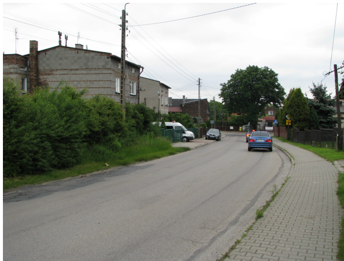
Fot. 2. Sarnów, RB1. Badany odcinek ul. Wiejskiej w kierunku skrzyżowania z ul. Główną.
