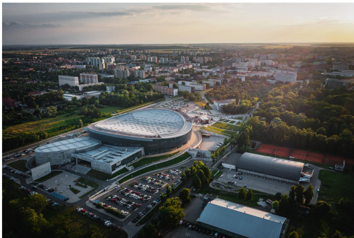
Fot. 3 Hala Gliwice - widok zewnętrzny obiektu.
