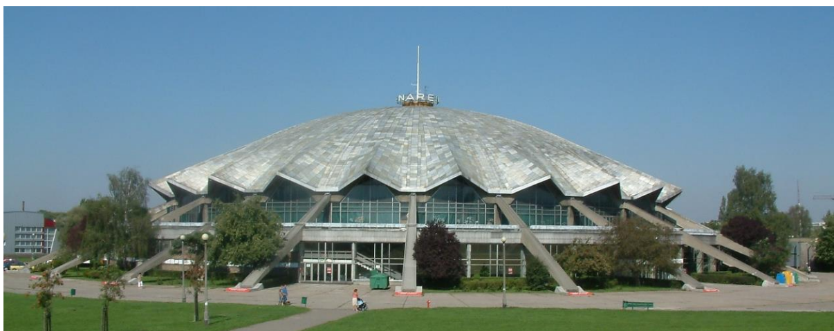
Fot. 25 Hala Arena - widok zewnętrzny obiektu.
