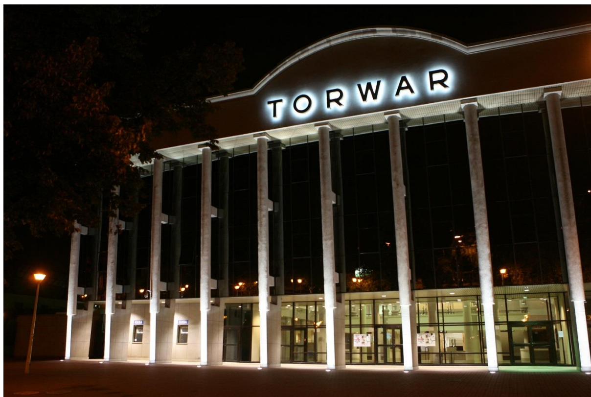
Fot. 17 Torwar I - widok zewnętrzny obiektu.
