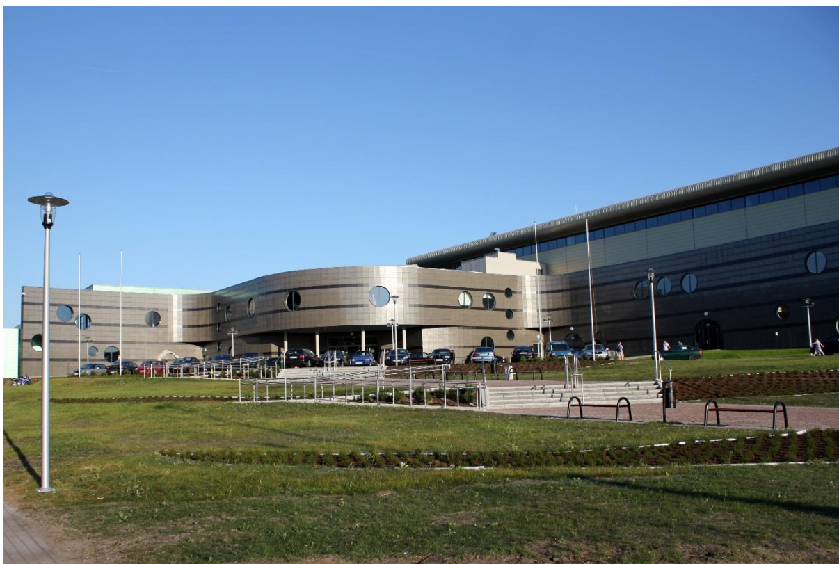
Fot. 35 CRS Hala Główna - widok zewnętrzny obiektu.
