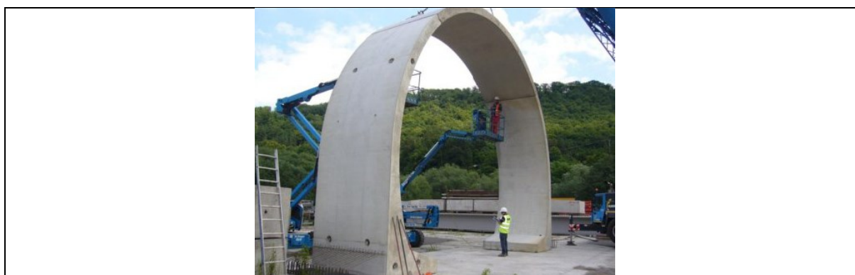
Rys.29. łukowe żelbetowe powłoki
