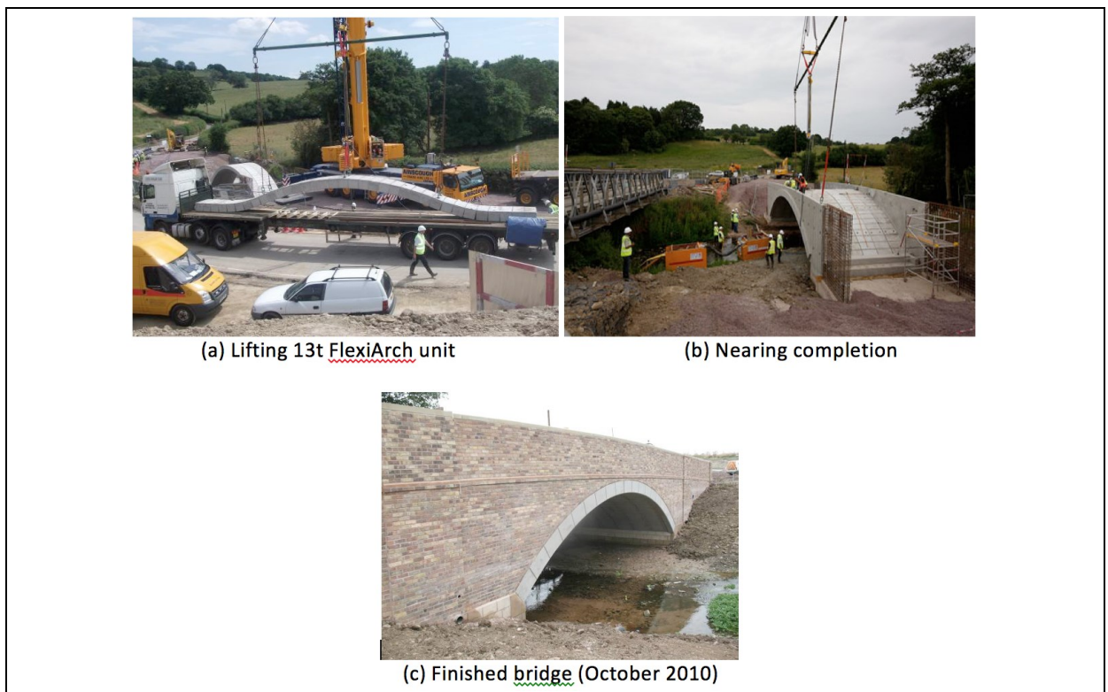
Rys.83. Proces budowy mostu typu Flexi Arch
