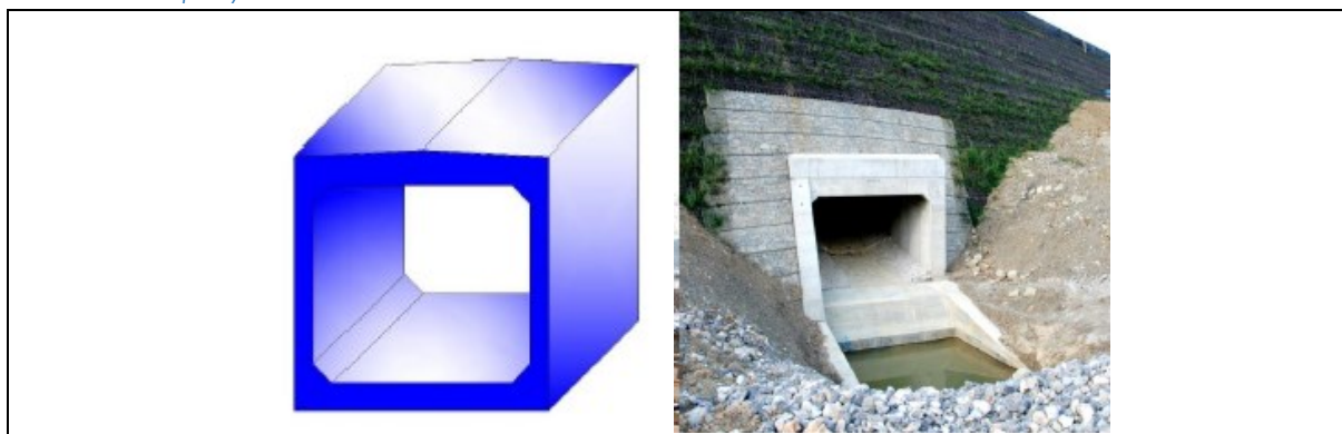
Rys.30. Ramowe przepusty żelbetowe zamknięte dołem
