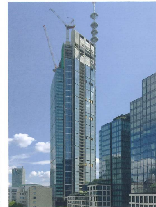
Varso Tower w Warszawie w czasie budowy, maj 2021 r. Z 310 m wysokości jest najwyższym budynkiem w Polsce i UE fot. Szczepreszyski / Wikipedia (CC BY 4.0)
