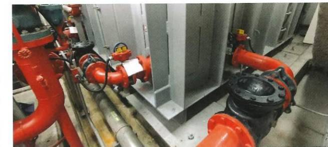
5 Zbiornik z wodą przeciwpożarową nad czwartym segmentem budynku fot. arch. autora
