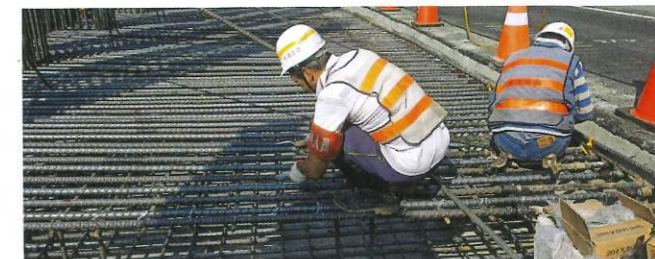
4 Konstrukcja żelbetowa drogi górskiej w rejonie sejsmicznym fot. arch. autora
