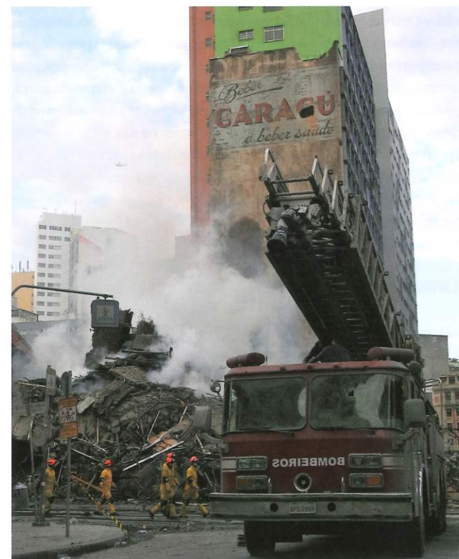
W 2018 r. ten sam budynek w wyniku pożaru uległ zawaleniu
