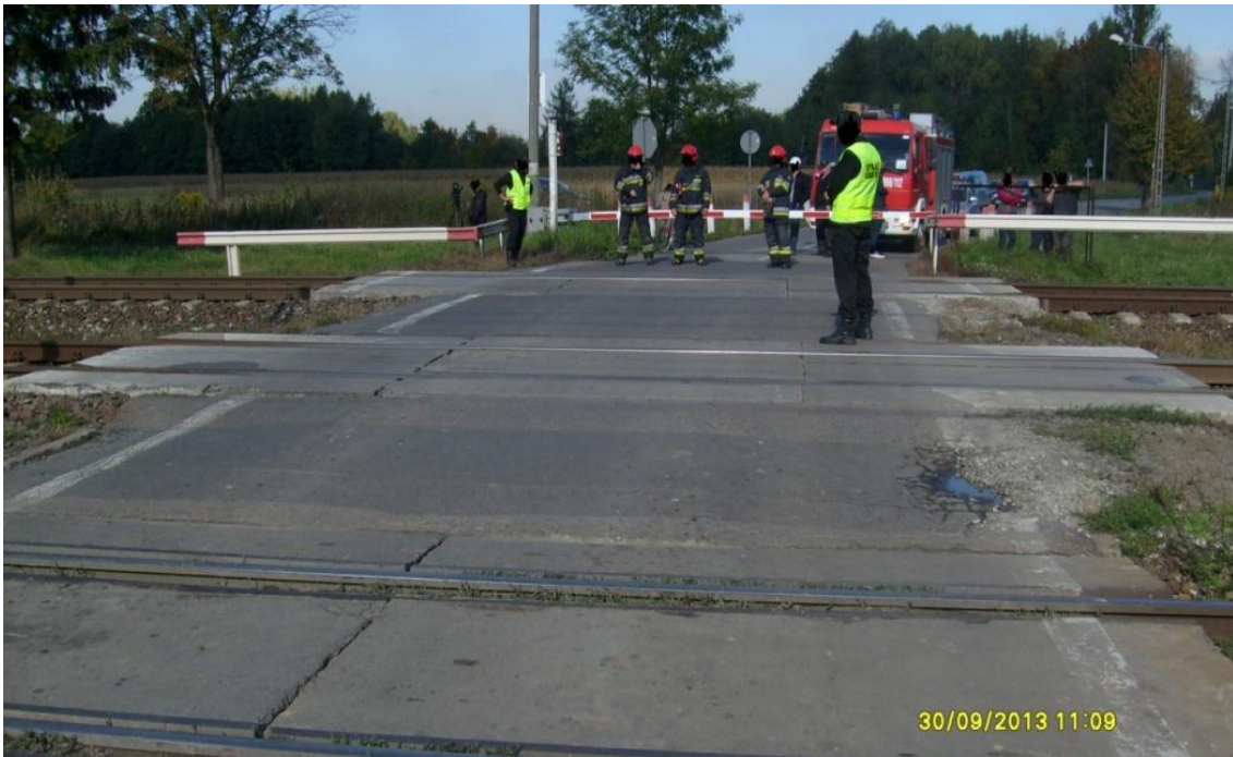
Widok nawierzchni przejazdu .
