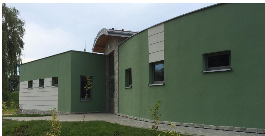
Rys. 9. Nowo oddany ustęp publiczny przy ul Bulwarowej w Rzeszowie.
