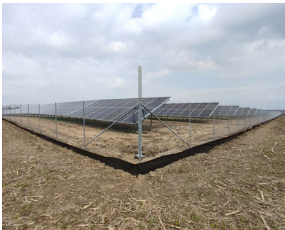
Zastosowanie wygradzeń na budowie PV Buszkowo
