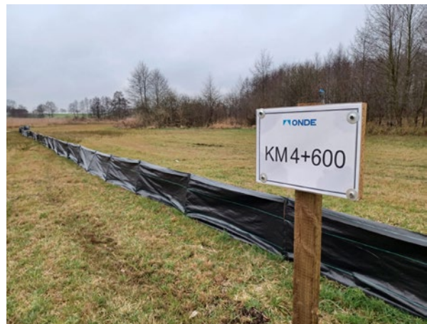
Zastosowanie wygradzeń na budowie Obwodnicy Lubrańca
