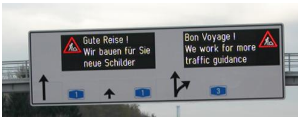
Rys. 7.98. Połączenie znaków odblaskowych i znaków o zmiennej treści
