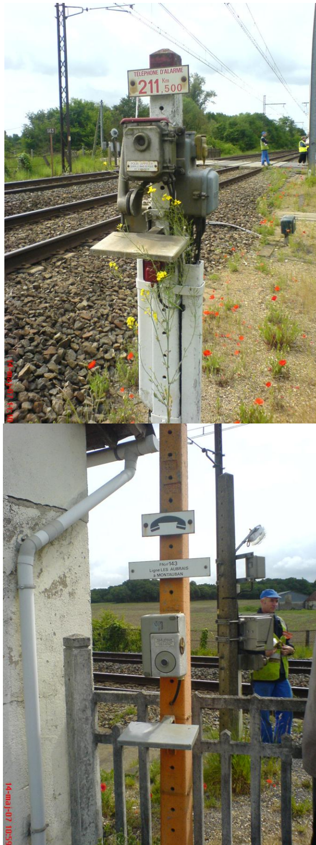
Rys. 8.50. Urządzenia do powiadamiania o zagrożeniu na przejeździe (Francja), źródło (zespół badawczy, 2015)
