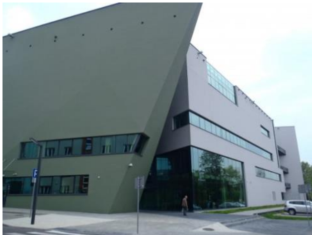
Nowy budynek ASP w Katowicach.
