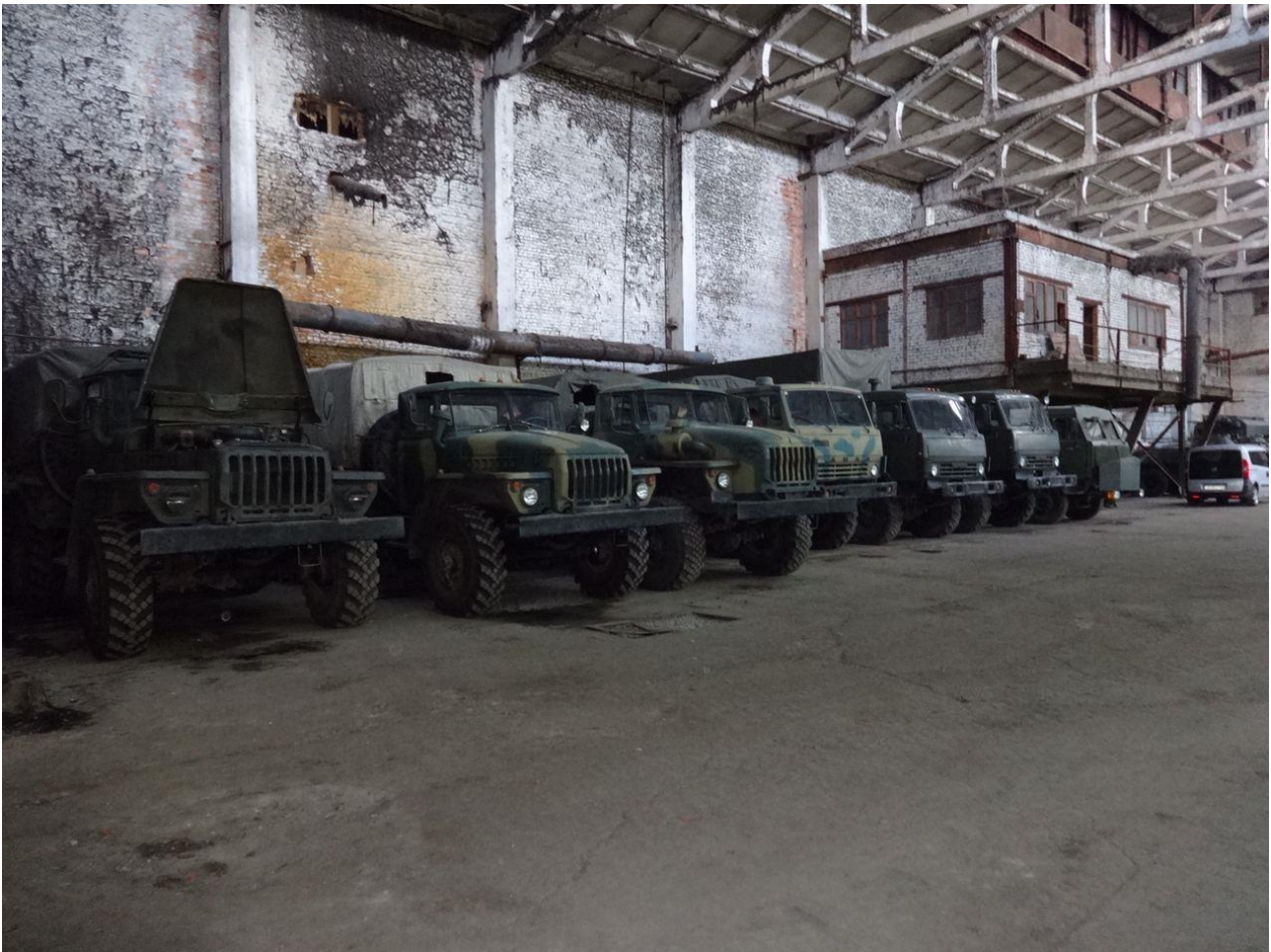
Завод ізоляційних матеріалів у Донецьку, який використовується як слідчий ізолятор "Ізоляція", вул. Світлого Шляху, 3, м. Донецьк, джерело: https://t.me/traktorist dn
