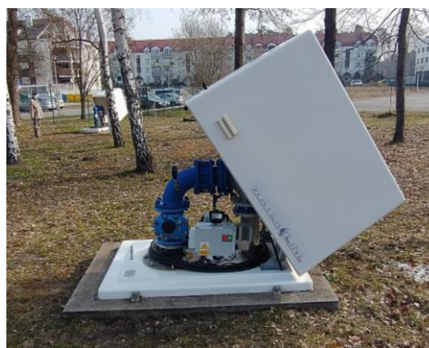
Źródło: Studnia z obudową naziemną, fot. PSSE Zielona Góra
