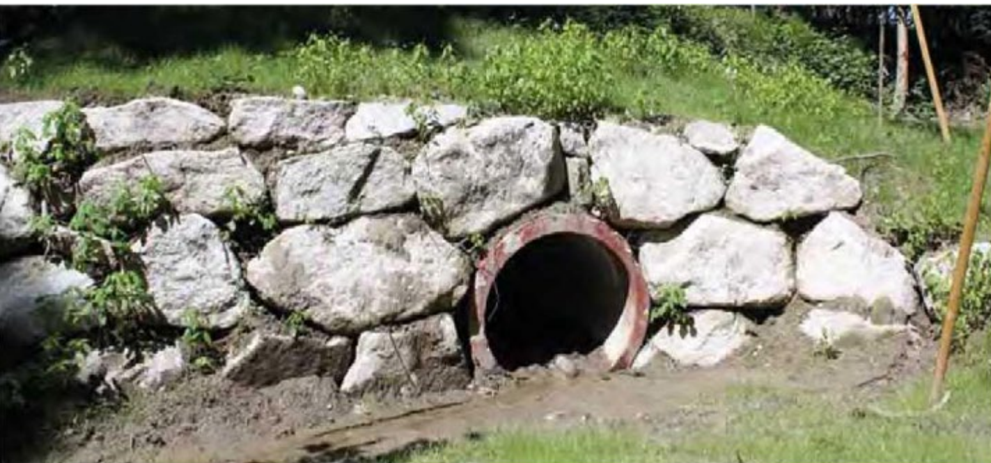
W ramach projektu TIB wykonano przejścia podziemne, które umożliwiają gatunkom przechodzenie w poprzek drogi.
