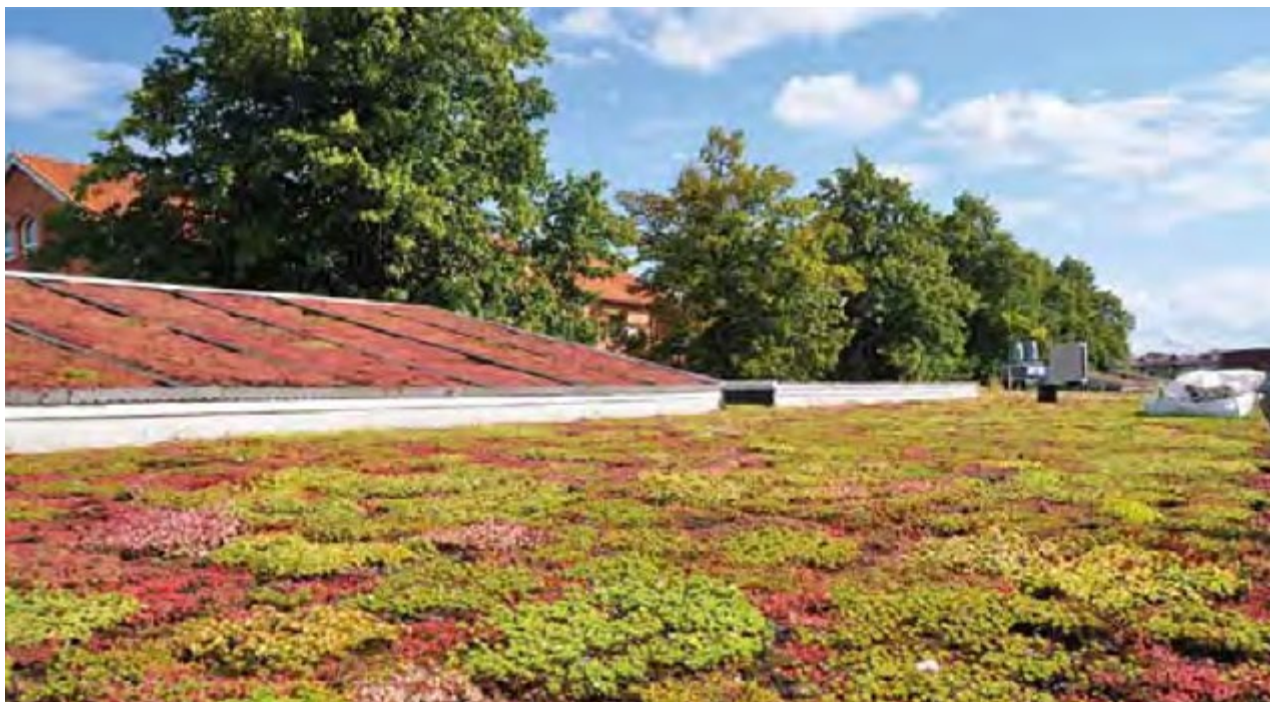
Wykazano, że zielone elewacje i dachy testowane przez GreenClimeAdapt zmniejszyły temperaturę wewnątrz budynków o 1–1,5 °C
