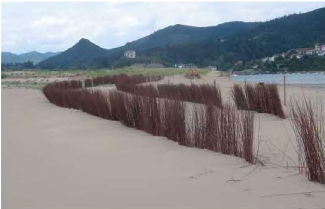
W ramach projektu Dunas Laida skonstruowano „płoty piaskowe” z gałęzi wierzby pomagające w zatrzymywaniu piasku i narastaniu wydm z upływem czasu.
