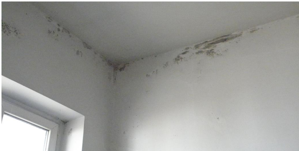
Zdjęcie 4: wykwity pleśni i wilgoci w pomieszczeniu magazynowym piekarni – autor Jagoda Jurga
