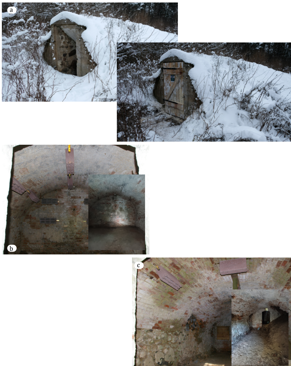
Ryc. 48. Przykłady adaptacji piwnic do zimowania nietoperzy: (a) wymiana drzwi (Puszcza Romincka, fot. Grzegorz Błachowski), (b, c) zwiększenie liczby kryjówek (Nadleśnictwo Oleśnica Śląska, fot. Iwona Gottfried)
