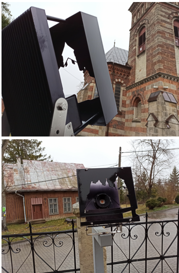
Ryc. 45. Nakładka na lampę kierująca światło na część budynku, która ma zostać oświetlona, co umożliwia pozostawienie zaciemnionej tej ściany budynku, gdzie znajduje się kryjówka nietoperzy. Tego typu nakładki montowane są już w Polsce w ramach projektu LIFE + Podkowiec Towers przez Polskie Towarzystwo Przyjaciół Przyrody „pro Natura” w obiektach będących schronieniami nietoperzy (fot. Tomasz Gottfried) Fig. 45. A mask restricting lamplight to the part of the building to be illuminated, shading the wall where the bat roost is located. Such masks are already being installed in Poland as part of the LIFE + Horseshoe Bat Towers project by the Polish Society Of Wildlife Friends „pro Natura” on lamps illuminating buildings with bat roosts (photo: Tomasz Gottfried)
