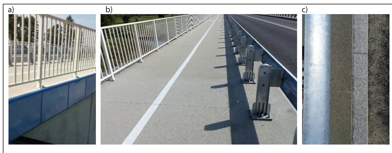
Rys. 5-13. Elementy chodnika na obiekcie mostowym: a) deski gzymsowe, b) kapa betonowa, c) krawężnik
