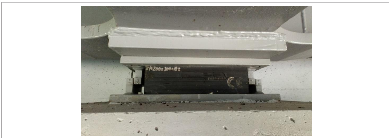
Rys. 5-2. Łożysko elastomerowe zamontowane na podporze
