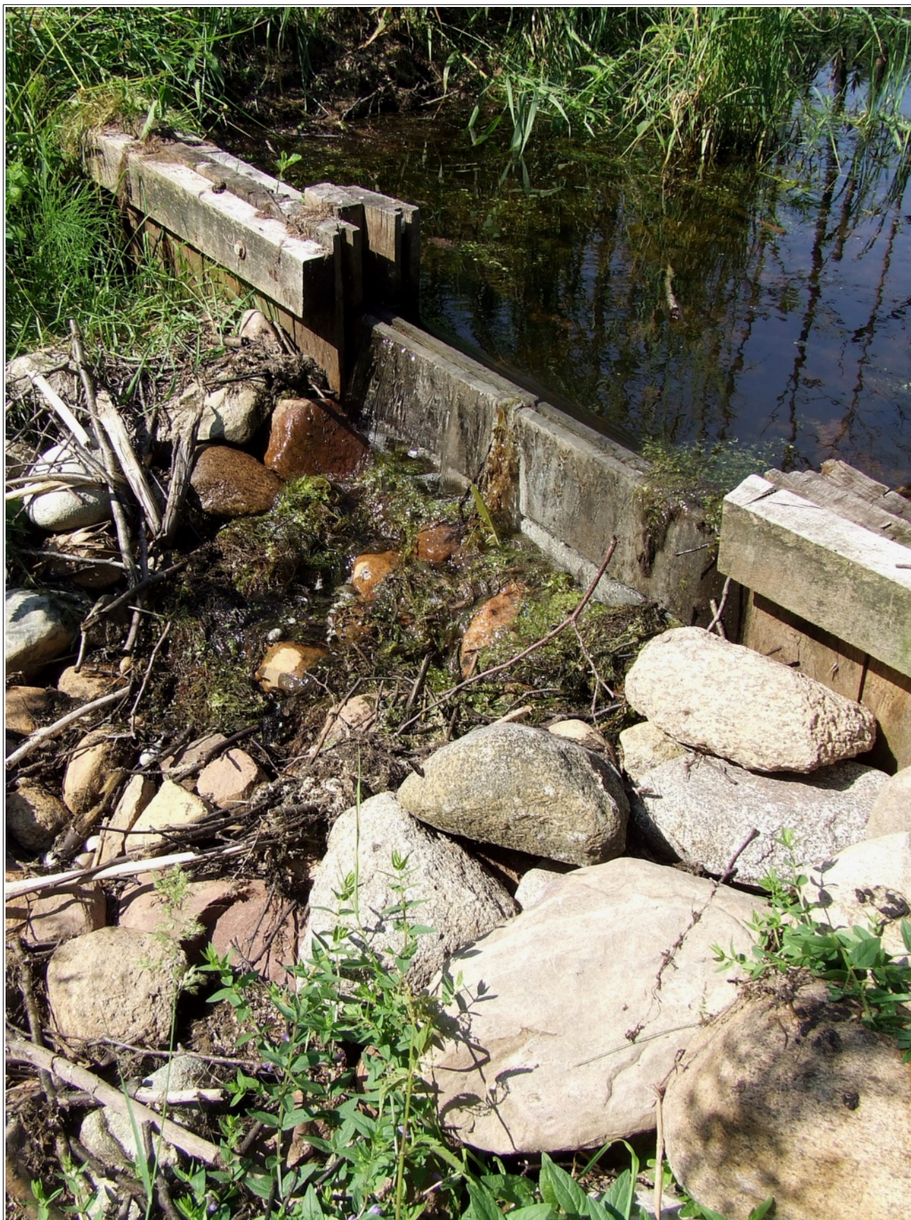
Fot. 12. Zastawka piętrząca wybudowana w ramach projektu budowy obiektów małej retencji – Leśnictwo Potok. (fot. Łukasz Galimski)
