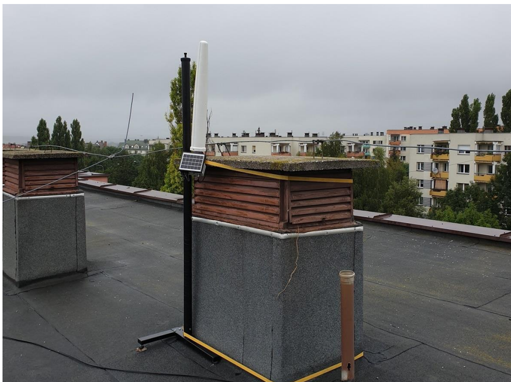
Rys. 2 Miejsce montażu pilotażowego SMS PEM – Massalskiego Kielce
