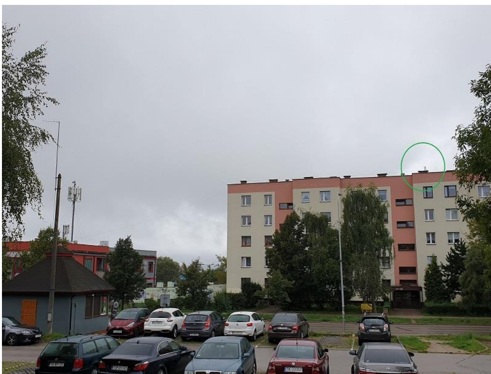
Rys. 4 Miejsce montażu pilotażowego SMS PEM – Massalskiego Kielce – widok z poziomu gruntu
