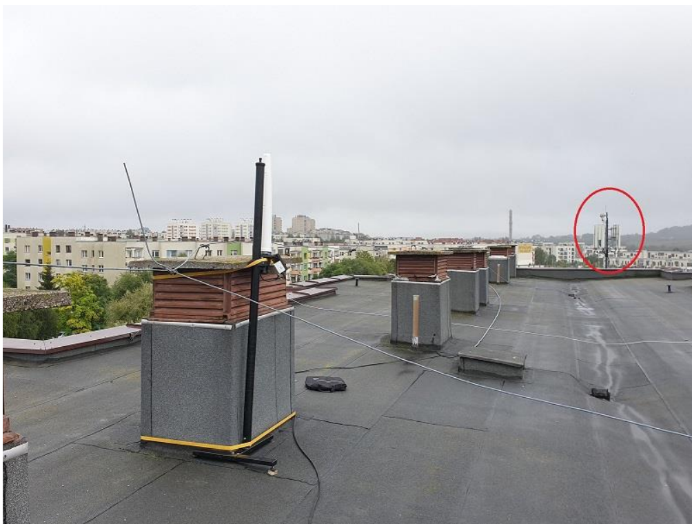
Rys. 3 Miejsce montażu pilotażowego SMS PEM – Massalskiego Kielce – widok na anteny SBTk
