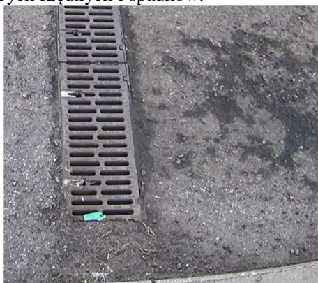
Fot. 5. Odwodnienie liniowe.
