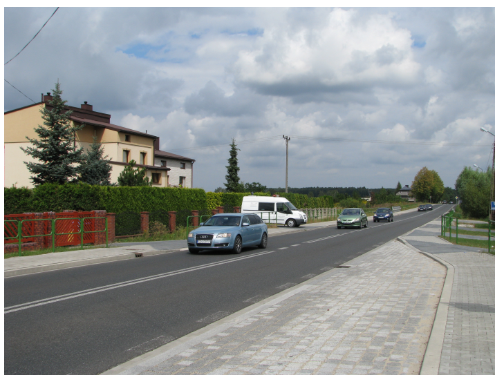
Fot. 9. Chruszczobród, RB3. Badany odcinek ul. Powiatowej w kierunku Ciągowie
