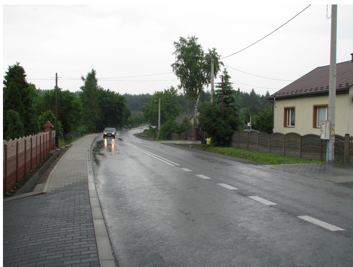
Fot. 5. Mitręga, RB2. Badany odcinek ul. Pilickiej w kierunku Ogrodzieńca
