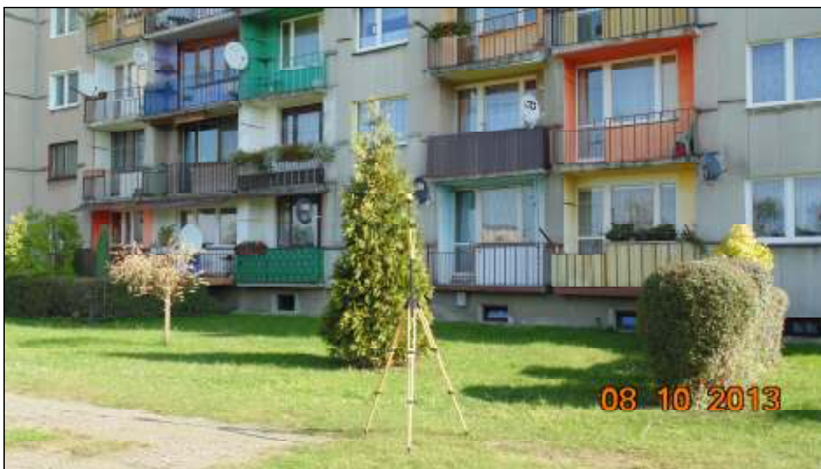
Fot. 2. Rejon badań, widok w kierunku wschodnim
