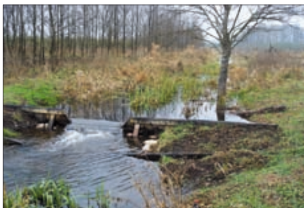
Fot. 15, 16, 17. Różne typy zastawek budowanych w ramach projektu
